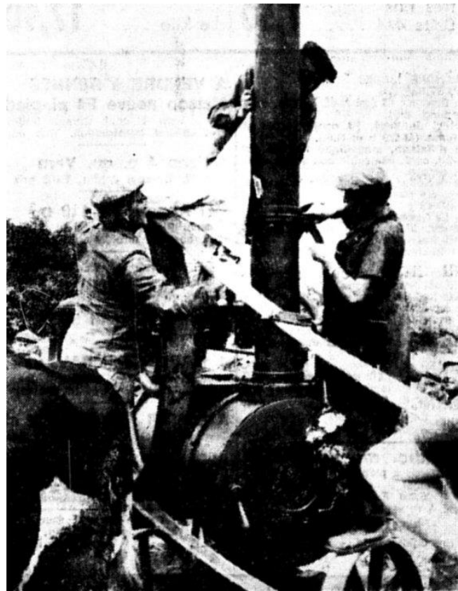
Préparatifs : M. Gefflot veille à tout
