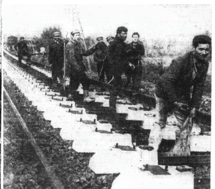
Une équipe d'ouvriers s'apprête à poser un rail sur les traverses de béton.
